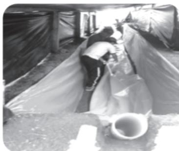
**Imagen 10.** Instalación tubería salida del gas. *Fuente:* autores.
